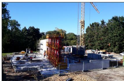
Au mois de septembre, pour faire le gros œuvre une imposante grue a été montée. En octobre, les fondations et la dalle béton coulées ont permis de voir les premiers murs de béton banché apparaître.
